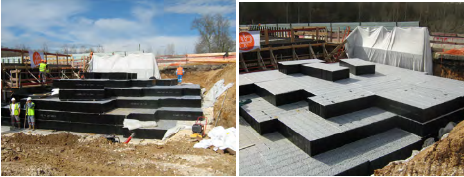
Figuur 78: Infiltratieblokken, Gien
