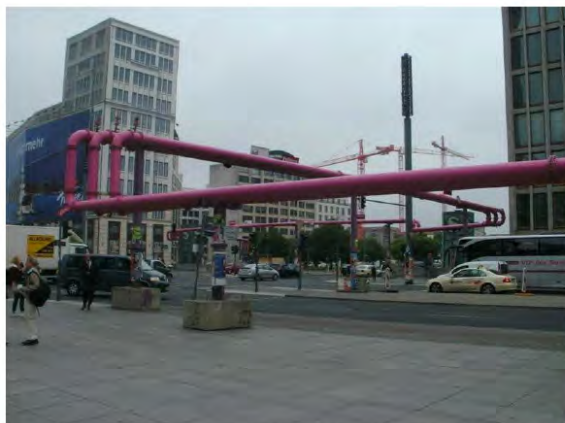
Figuur 91: Bovengrondse waterleidingen in het straatbeeld van Berlijn. De ondergrond van Berlijn is moerasachtig en het grondwater niveau is vrij hoog. In het centrum is dit niveau bijna op maaiveld. Wat betekent dat wanneer er een nieuw gebouw gebouwd wordt, de fundering in het water staat en de bouwplaats constant blank staat door grondwater. Dit water moet constant weggepompt worden en dat gebeurt via de roze/paarse/blauwe buizen die door de stad zijn gebouwd. Het systeem pompt het grondwater op en loost het op het oppervlakte water.
